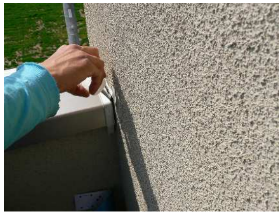
⑧ 端部プライマー処理
