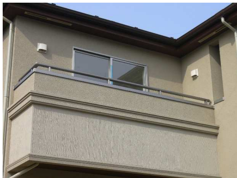
⑯ 外観仕上がり
