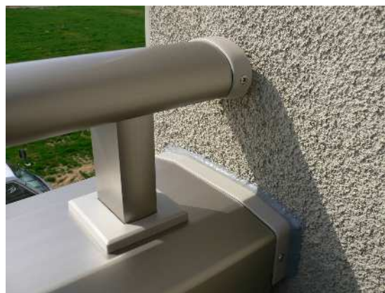
⑭ 端部仕上がり
